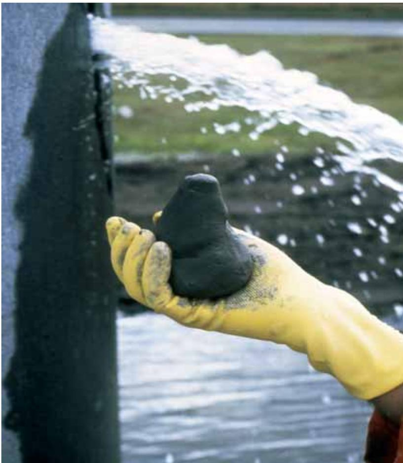
**WATERPLUG®**, mortier expansif, à prise très rapide, pour arrêter les venues d'eau dans le béton et la maçonnerie. Il peut aussi être utilisé pour étancher les joints d'embase (sol / murs).
