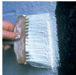
**THORO® ACRYL 60**, est un polymère 100 % acrylique, pour améliorer l'adhérence ainsi que les caractéristiques mécaniques et chimiques de mélanges sable / ciment, mais conçu spécialement pour être utilisé avec d'autres produits **THORO®** tels que **THOROSEAL®** ou **THORO® TECT CR**.
