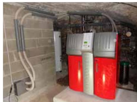
Chaudière de 16 kW avec commutation automatique double RAPS
